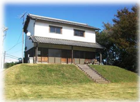
みつかは、洪水に備え敷地の一部を高くして避難小屋を建てたものです。
